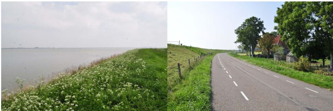
Figuur 9: Gouwzee, water aan de voet van dijk (links); Bebouwing langs de dijk (rechts)
